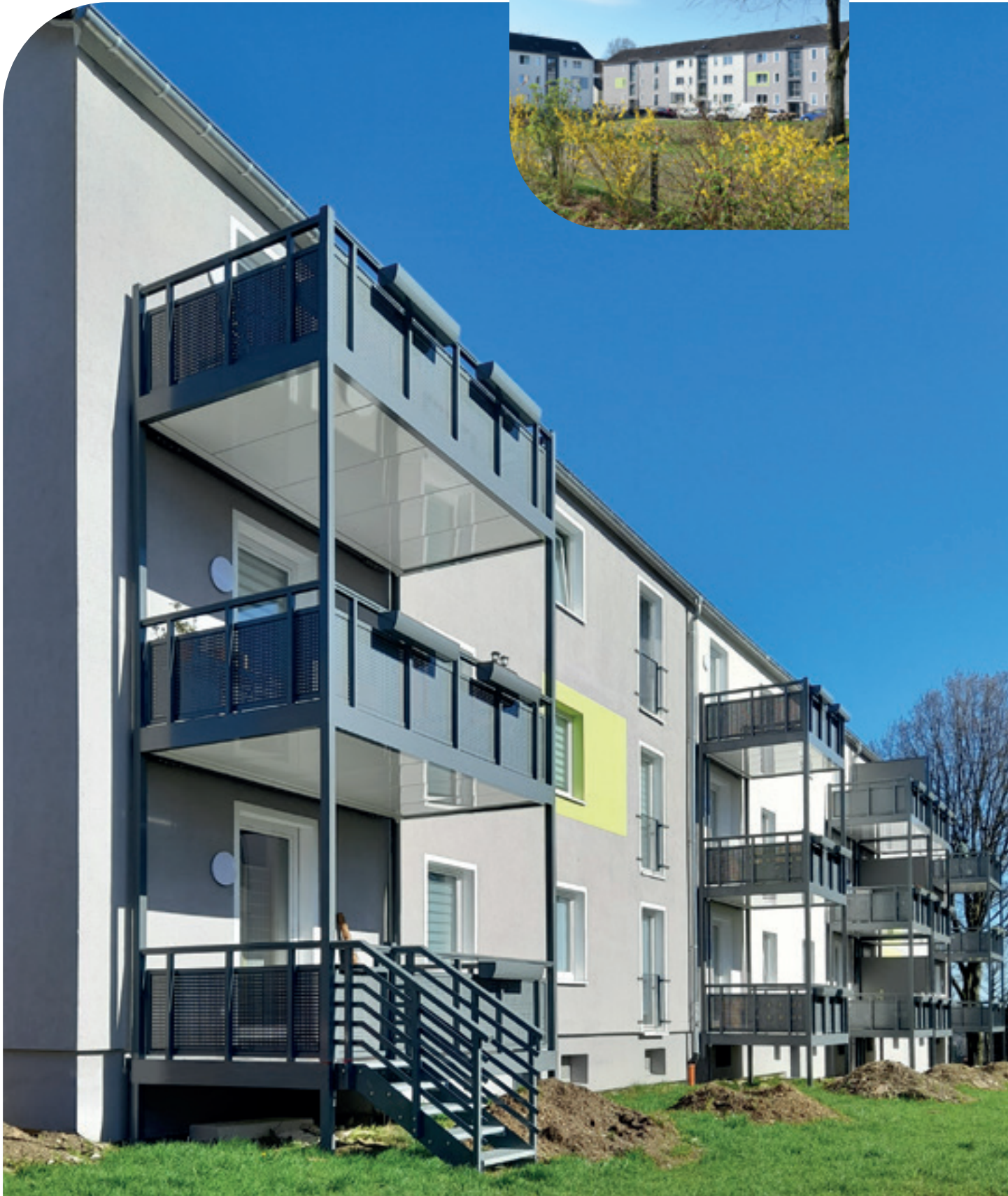
Die frisch sanierten Wohnungen in unserer Klimaschutzsiedlung „Alte Vömix“ kommen bei den Mietern gut an.
